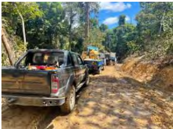
作業道を通じて資材を運搬
