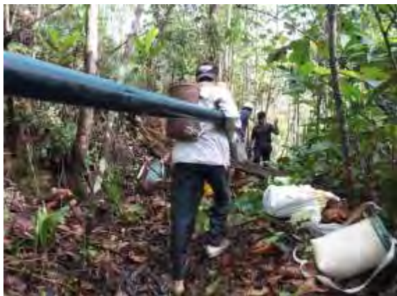
導水ルートに沿ってパイプを敷設
