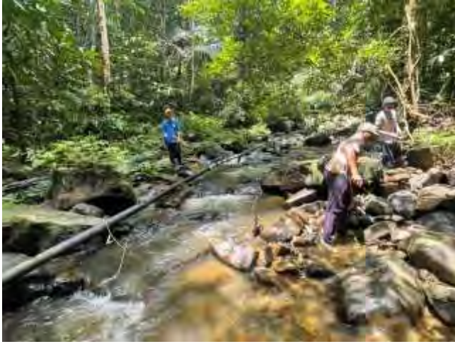
水源地と導水パイプルートの調査
