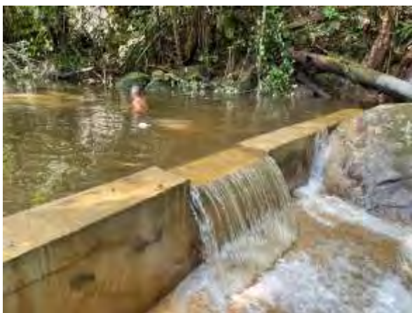
水源地に堰堤が完成
