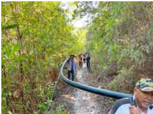
導水パイプの交換・敷設を開始
