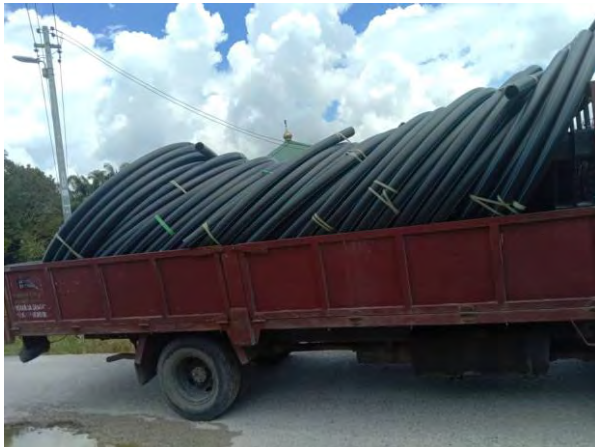
導水用HDPEパイプを運搬
