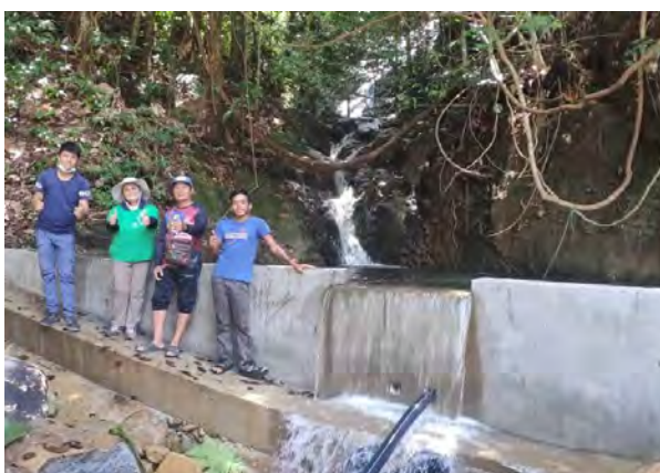
水源地に堰堤が完成
