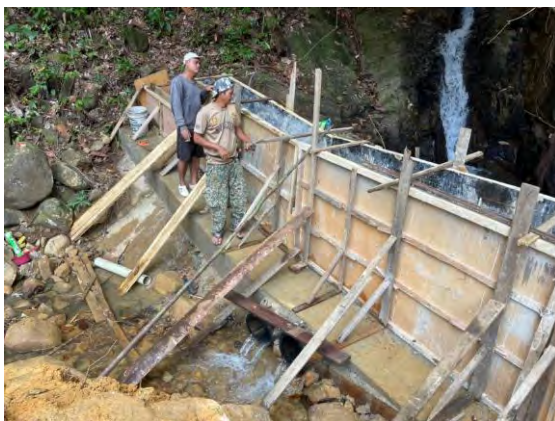
型枠を造り、コンクリート打設
