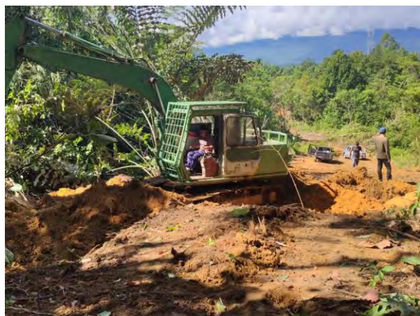
作業道の整備
