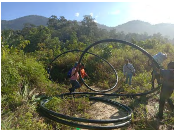
導水用パイプの接続作業
