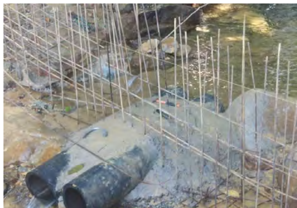
配水パイプを設置し、鉄筋で枠組みづくり
