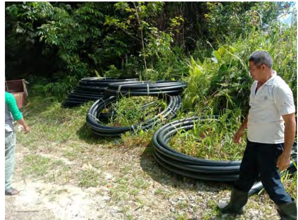
導水用HDPEパイプを運搬
