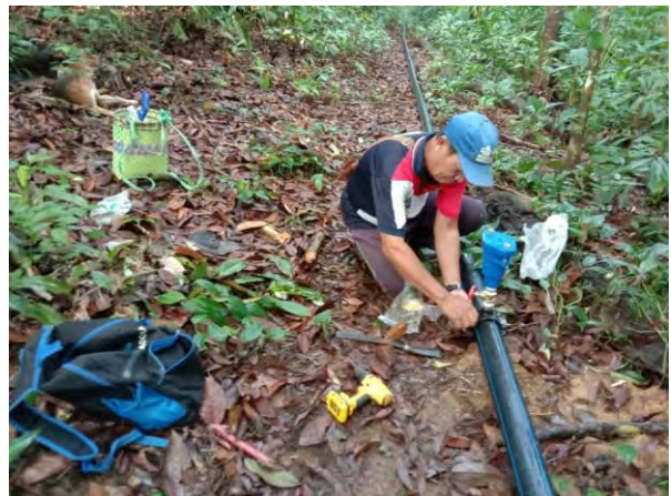
導水用パイプの接続作業
