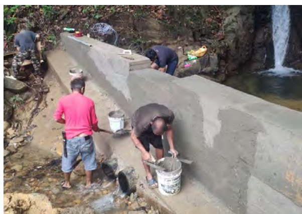
最終仕上げ作業
