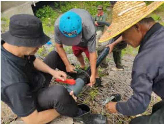
導水パイプの接続作業
