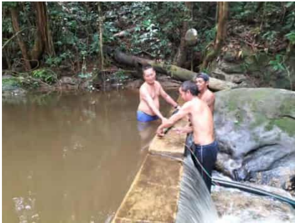
堰堤取水口の点検と清掃作業
