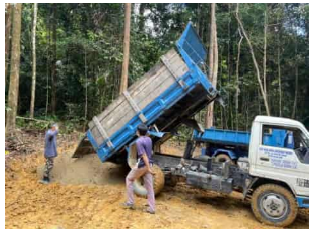
水源地付近へ工事資材を搬入
