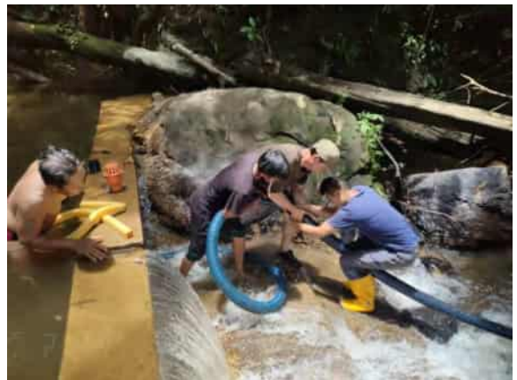
堰堤取水口の清掃と調整
