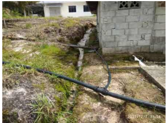
各戸へ取水パイプを接続
