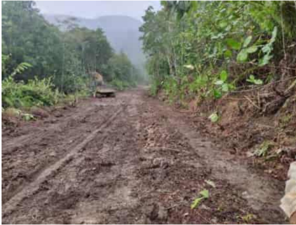
作業道を整備
