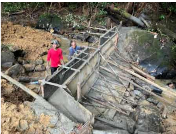
型枠を作り、コンクリート打設
