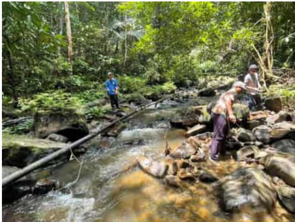
水源地と導水パイプルートの調査
