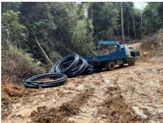
導水ルート付近へパイプを移動
