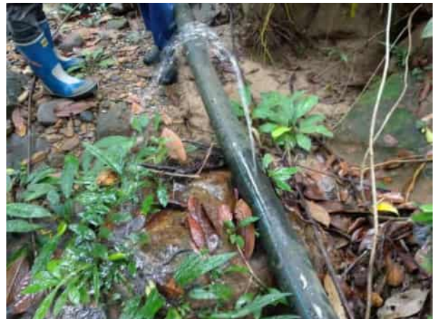
老朽化した既設の導水パイプ
