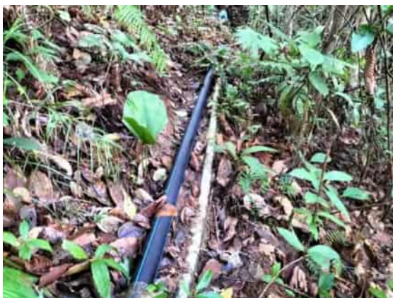
HDPEパイプへ交換・敷設
