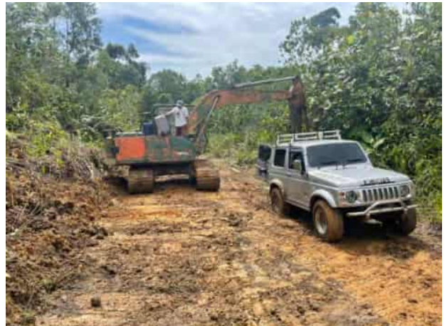
旧林道を作業道として整備
