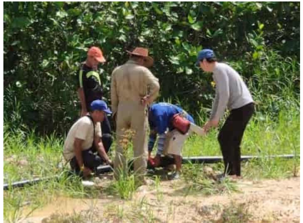
導水パイプの点検と調整
