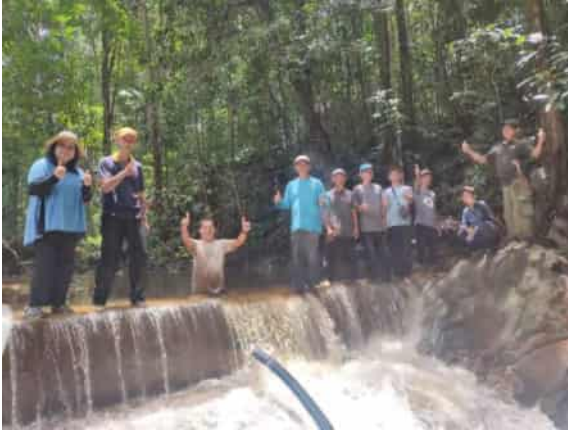
水源地の堰堤に導水パイプを接続
