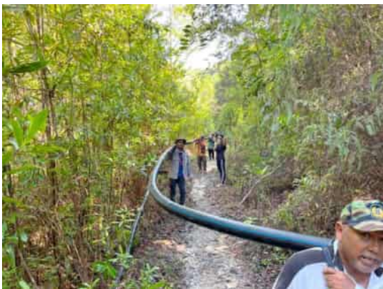
導水パイプの交換・敷設を開始
