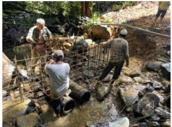
鉄筋で堰堤の骨組みづくり
