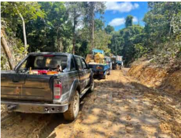
作業道を通じて資材を運搬
