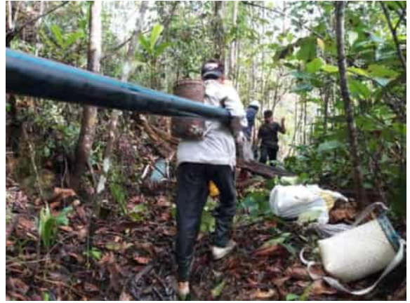
導水ルートに沿ってパイプを敷設
