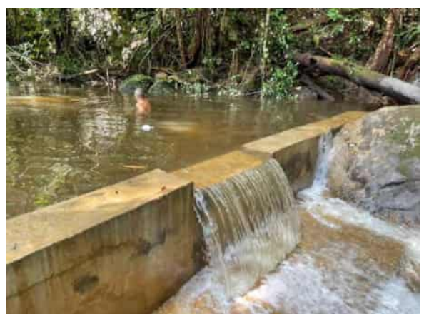
水源地に堰堤が完成
