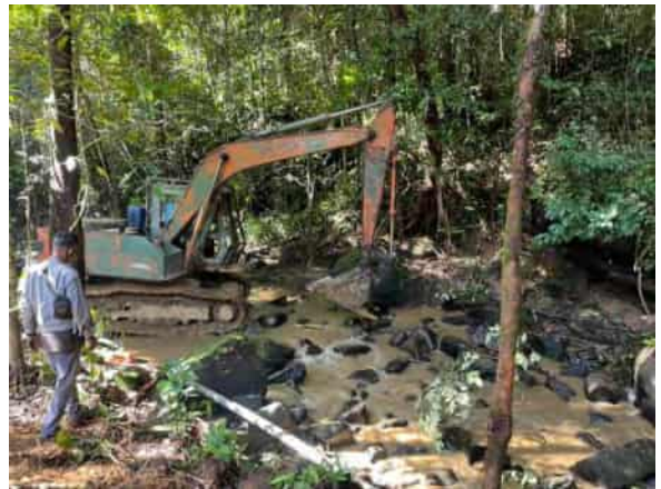
重機で堰堤造成場所を整備
