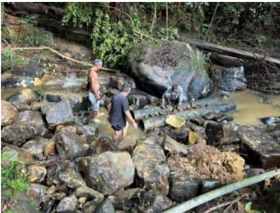
配水パイプを設置
